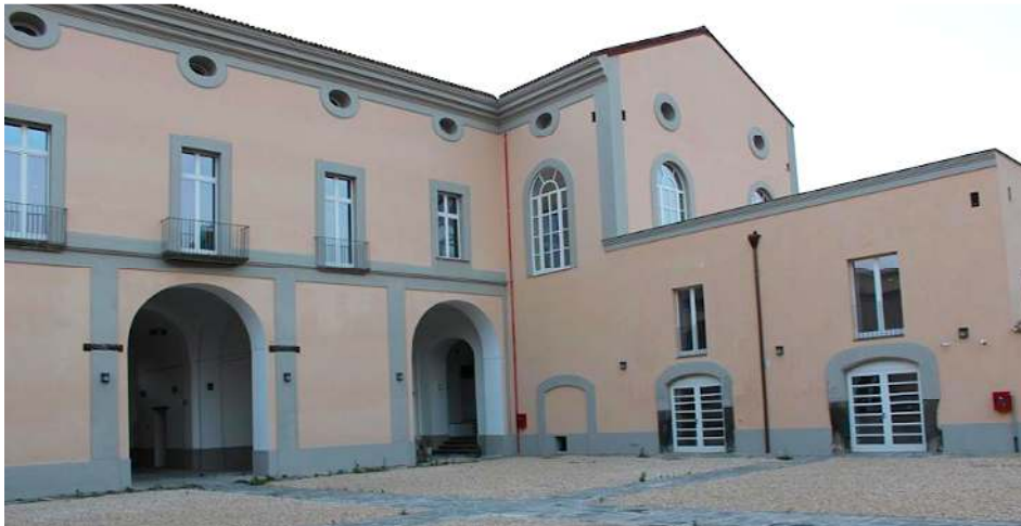
Fig. 17. Casalnuovo, cortile interno del Palazzo Lancellotti Durazzo.
